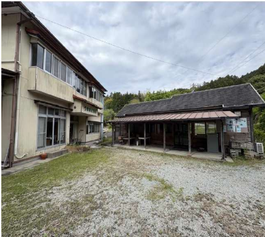
鑑定評価対象外未登記物件(南西方向から)
