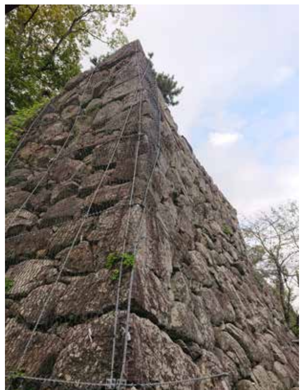
【写真 2】石垣No.227( 左 )・No.228( 右 ) の状況
