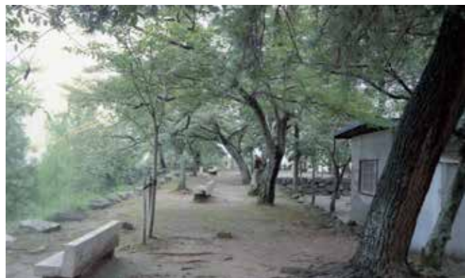
【写真15】石垣解体前の状況（北西から）
