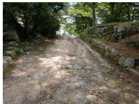
天守台周辺表土流出状況
