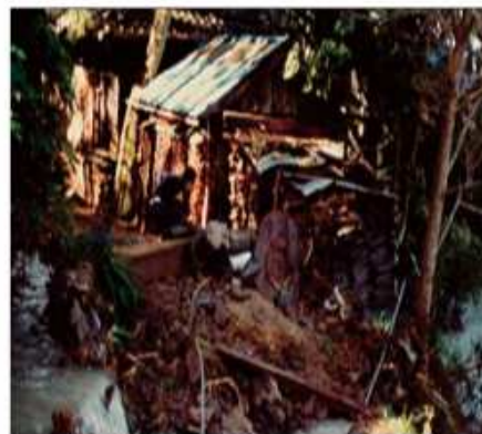
▼昭和57年9月台風18号 伊太谷川右岸(土砂災害)
