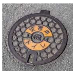
マンホール トイレ(穴)
