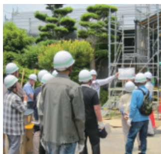
工事の現場説明会
