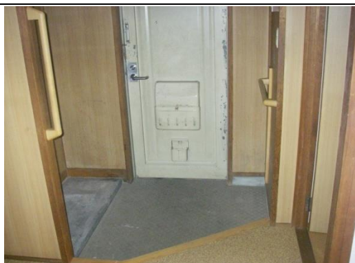
①玄関【手摺設置済み】
