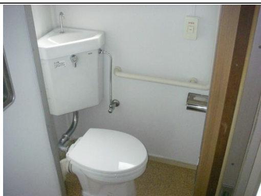
⑤トイレ【手摺設置済み】
