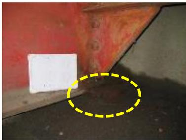
【橋座面の土砂堆積・滞水】
