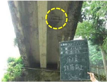
【点検で発見した損傷(鉄筋露出)】
