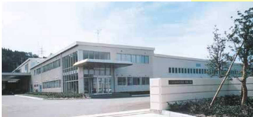
松阪工場外観
