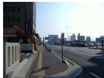
朝日町等の国道 166 号沿い地区
