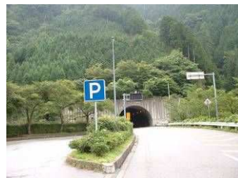
飯高町木梶の国道 166 号奈良県境付近
