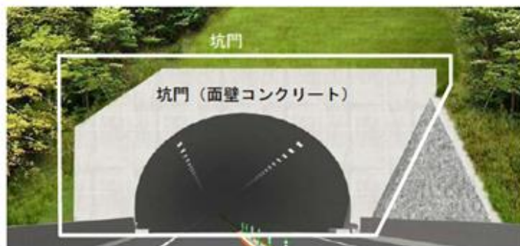
別図-1.2 点検対象箇所（トンネル坑口部）
