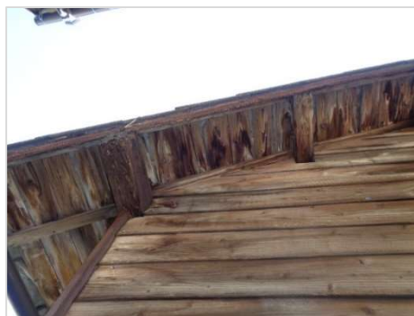
春日西住宅の小屋組の進行した腐朽
