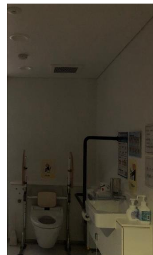
停電時のトイレ内
