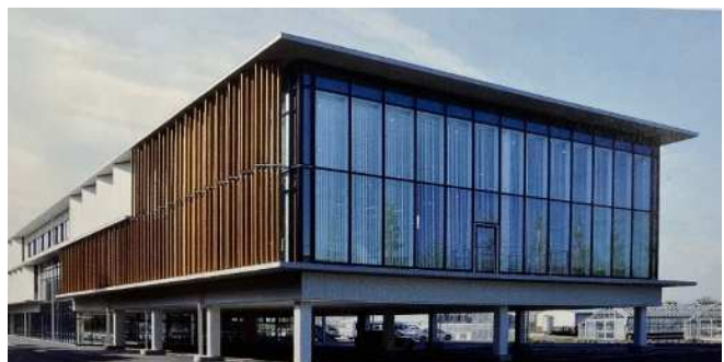
C 棟および図書館
