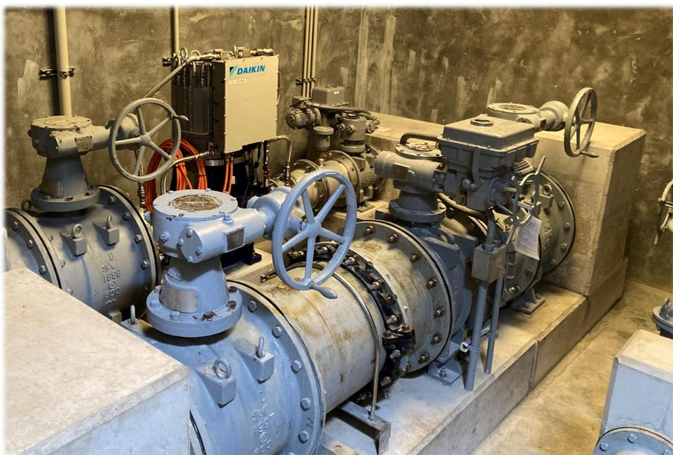
マイクロ水力発電システム (75kWクラス)
