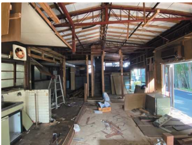
<改装中の古民家>
