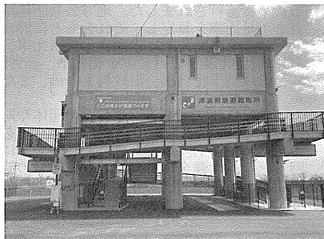
松名瀬津波避難タワー建設 (松名瀬町)
