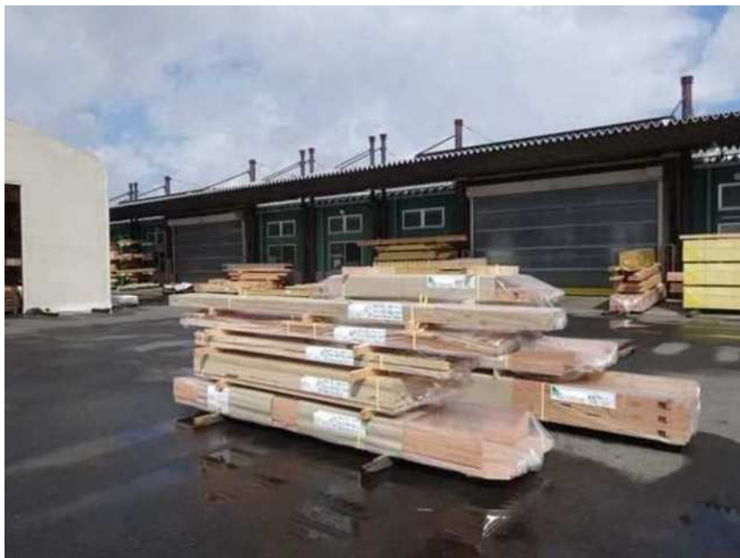
③現場への構造材納入状況
