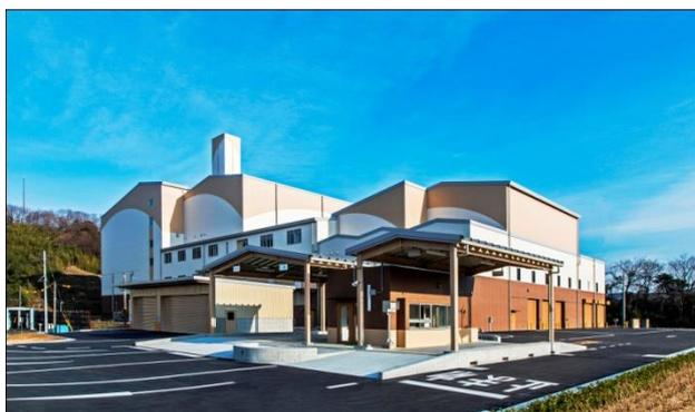
本施設は、平成 17 年 1 月の市町村合併後の市内全域のごみ処理一元化を目的に、平成 27 年 4 月に本格稼働しました。ごみ焼却施設は熱回収施設とも呼ばれ高効率発電システムを採用し、ごみ焼却時の熱を利用して発電を行い、施設の使用電力を賄い、余剰電力は松阪新電力株式会社に売却しています。
