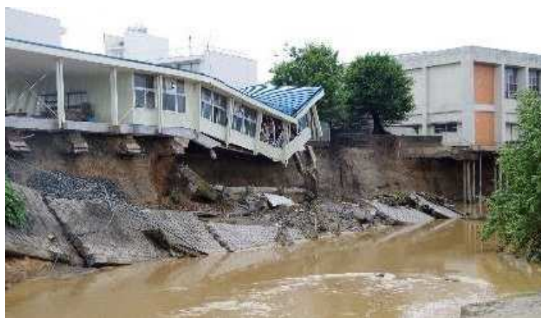
平成29年7月九州北部豪雨【九州地方整備局提供】 (福岡県朝倉市・筑後川水系桂川)
