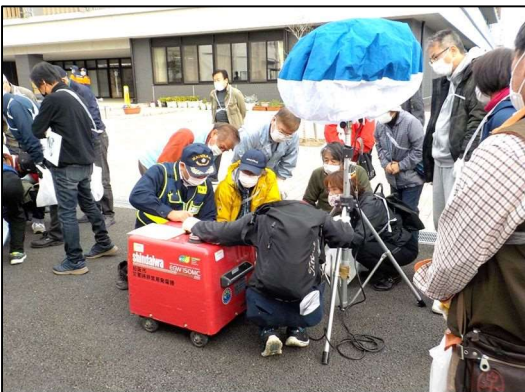
鎌中地区防災訓練にて 発電機の操作方法
