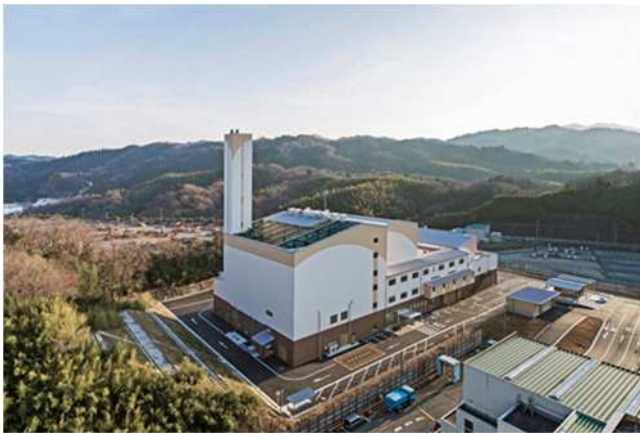
写真3-1 (松阪市クリーンセンター)
