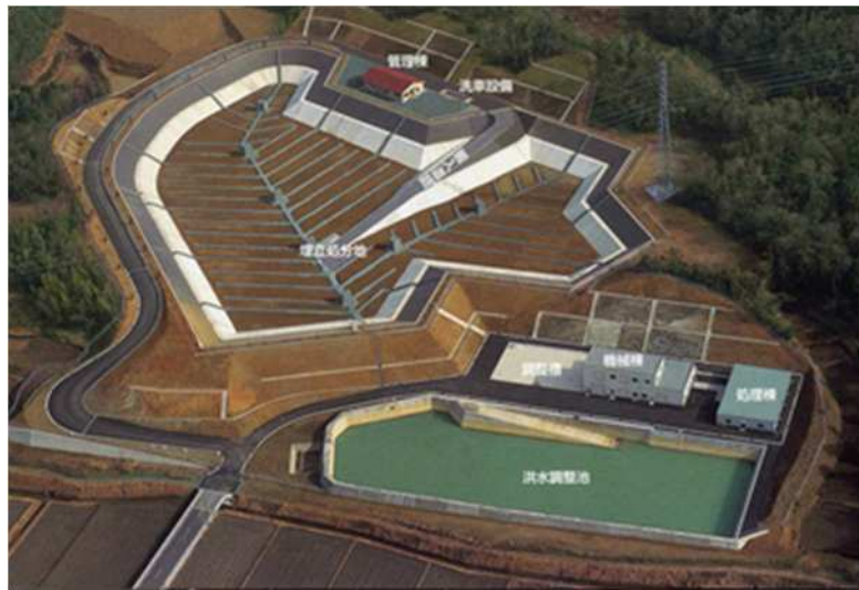
写真3-3 (松阪市一般廃棄物最終処分場)
