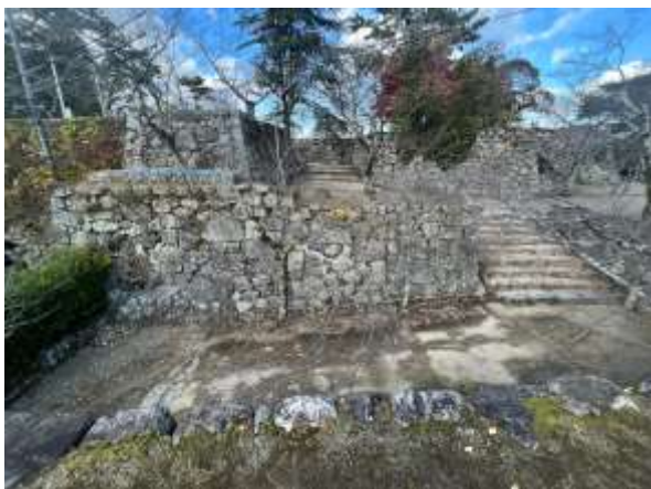
本丸上段地区から二ノ丸東側地区へ続く城内道
