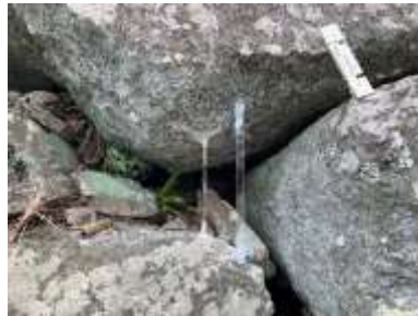
定点観測用に設置したガラス棒とクラックゲージ
