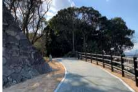
二ノ丸北西地区および土塁地区のプラスチック製の擬木柵
