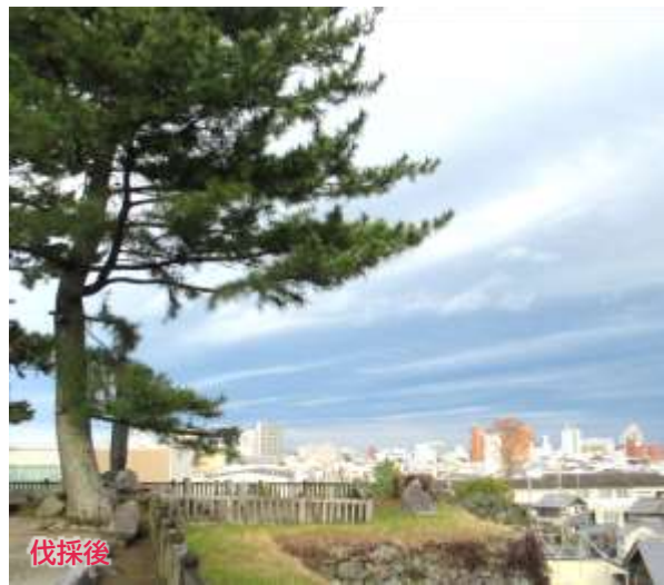
石垣(No. 325)上面に生育していた樹木を伐採
