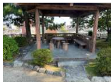
東屋(コンクリート擬木製)
