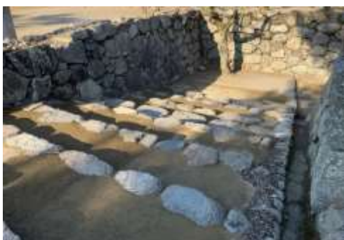
踏面を改良土にて埋め戻した状態
