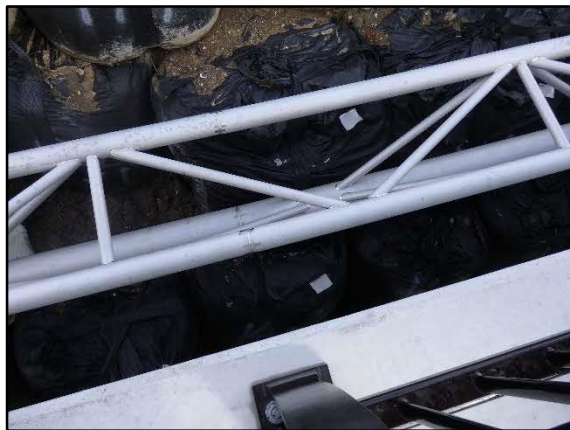
【写真－３】トラス部現場溶接箇所
