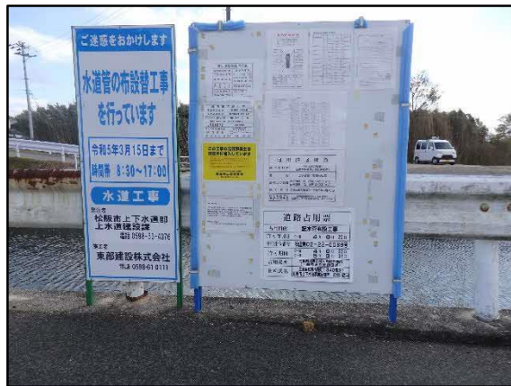
【写真－４】百々川左岸工事標識
