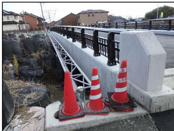
【写真－１】水管橋全景 伸縮ジョイント、落橋防止工
