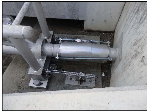
【写真－２】左岸側可動支承、橋門工
