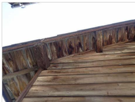
春日西住宅の小屋組の進行した腐朽
