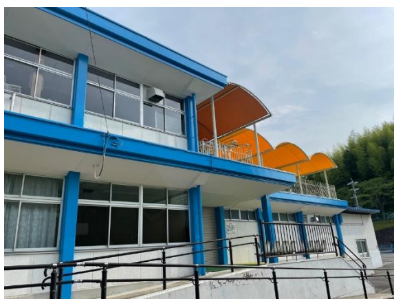
管理棟・屋上テント
