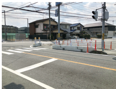
◀改修された鎌田中学北交差点
