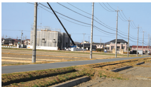
▲避難タワーへの避難路の状況
