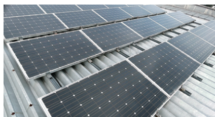
▲10年前に9.8KW、350万円で設置。 市役所の発電量の1/4、工事費用は1/10
