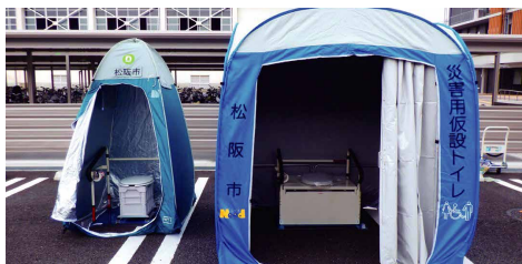
マンホールトイレ
