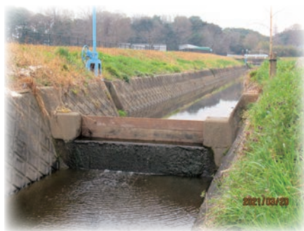
▲管理が重要である農業用施設の「井堰」、「樋門」等
