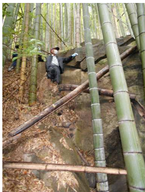
落下の危険がある別の大岩、高さ6m、胴回り15m
