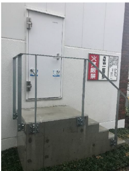
■ 塀に設けた防水扉
