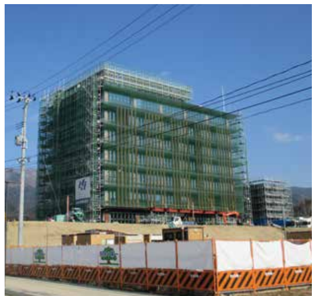
今春に完成する陸前高田市役所の新庁舎
