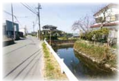
▲フラップゲートが設置予定の百々川
