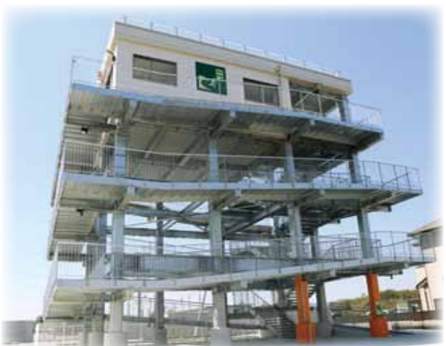
▲津波避難タワー（和歌山県田辺市提供）
