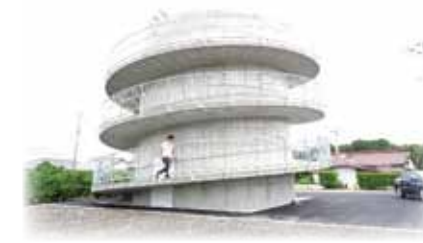
▲究極の津波避難施設（御浜町） 災害時要配慮者に 優しい！コストも安い！！
