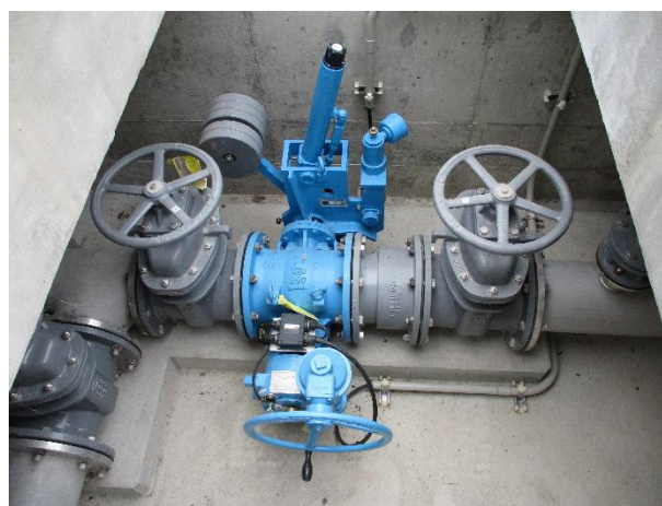
図 3-7 緊急遮断弁
