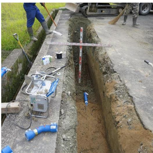
写真-5 水道配水管施工状況
