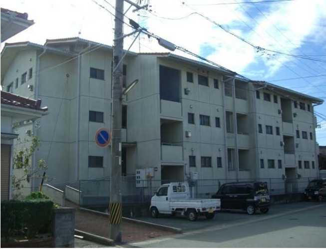
京町改良住宅
