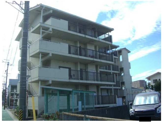
京町改良住宅
