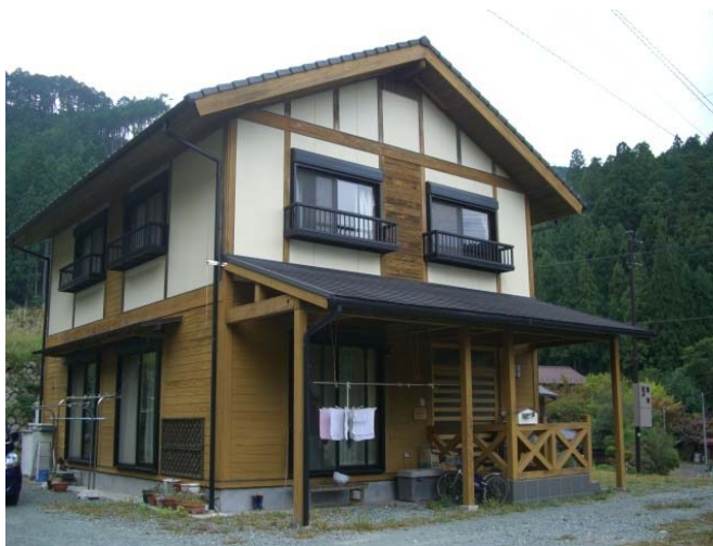
波瀬農林業就業者住宅
