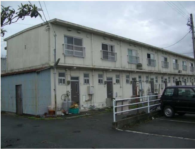
幸生町改良住宅
