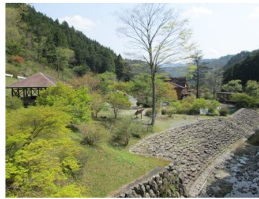
堰堤から施設を望む
