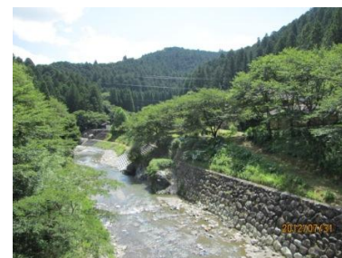
栲橋から施設を望む
