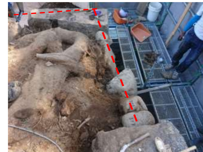
飛び出した築石
