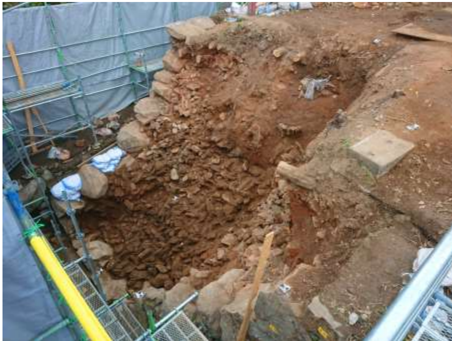
解体後の様子
