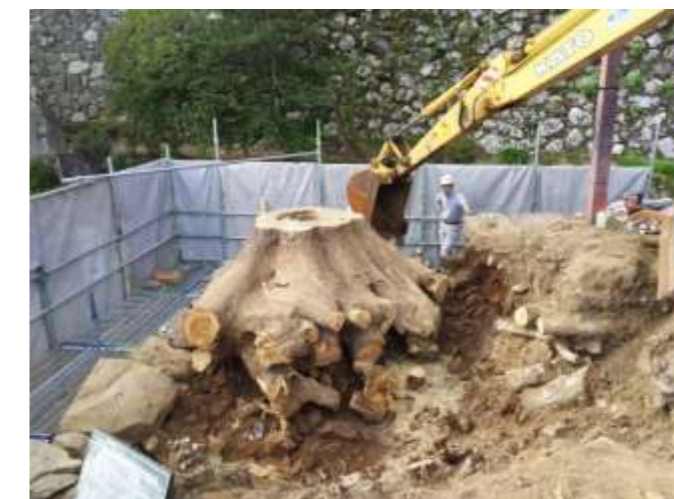
切り株の撤去作業
