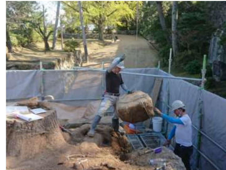
築石の解体風景
