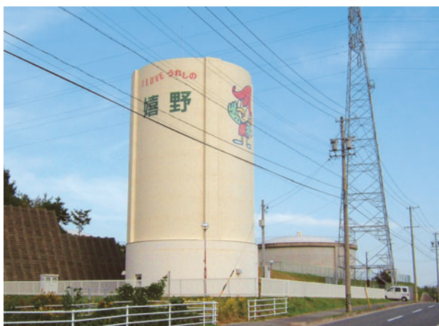
天花寺配水地
