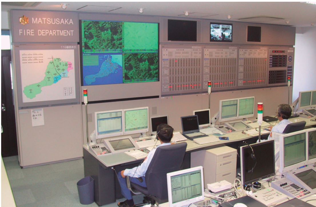
消防指令センター
