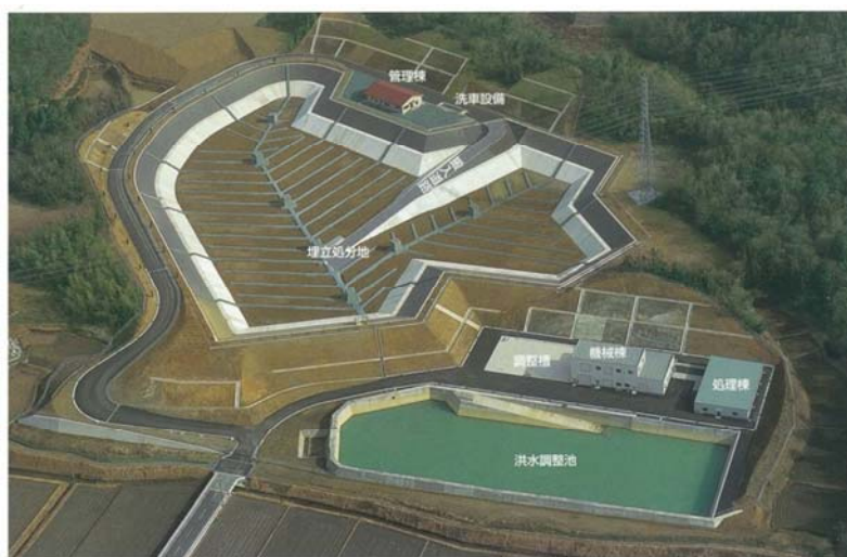
写真 2-1-1 現最終処分場（供用開始時）
