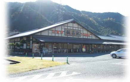
飯高地域資源活用総合交流促進施設 (道の駅飯高駅)
