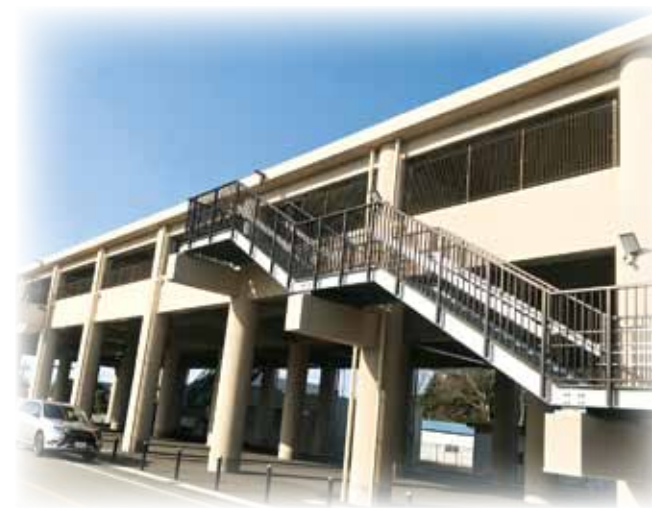
▲明和町の津波避難タワー
