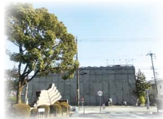
▲解体中の翠松閣
