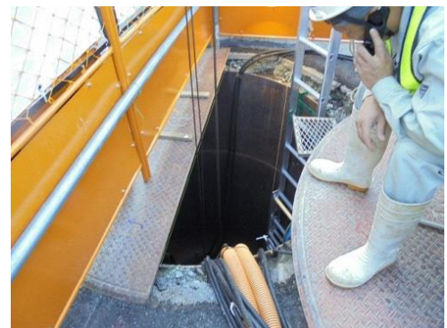
【写真-4】 立坑での推進作業
