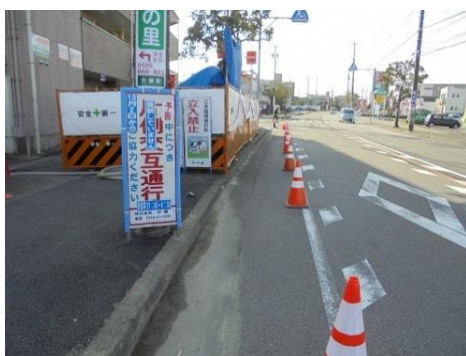
【写真-3】 立坑付近道路占用状況
