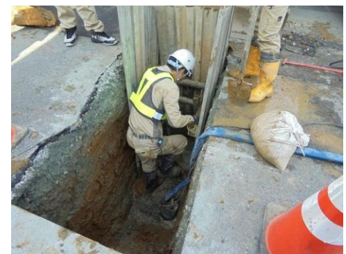
【写真-6】 下水本管への接続工事
