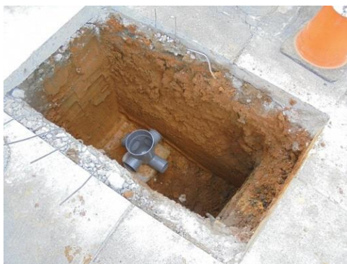
【写真-5】 公共汚水柵設置 (宅地側)
