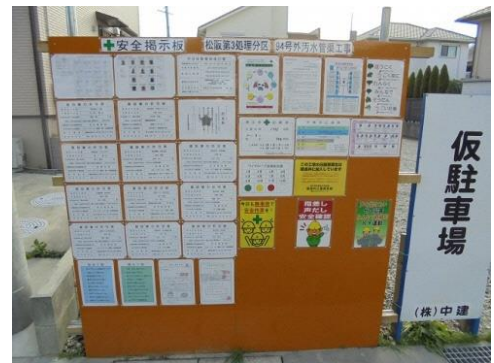
【写真-2】 施工個所近くでの標識掲示
