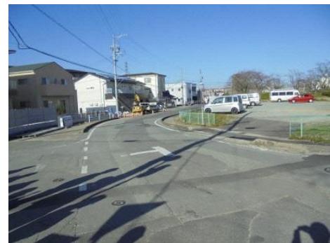
【写真-6】 下流部埋設済区間 平成 28 年度施工済
