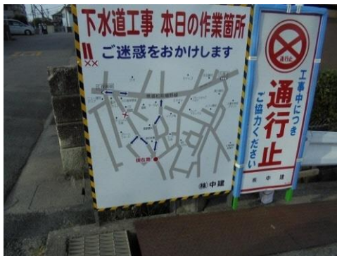
【写真-1】 工事個所迂回路標識 (×印工事個所)
