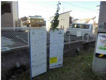
【写真-3】 工区中ほど標識掲示
