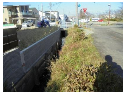
【写真-4】 下流部仮止水版 (左側住宅側が自主的に設置)
