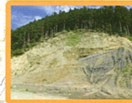
②栗野・田引の中央構造線露頭 新しく発見された中央構造線露頭。林道の脇にある
