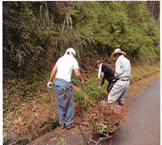
側溝にたまった泥土を上げる
