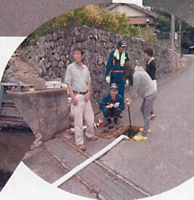
ホース伸長完了による消火栓開閉
