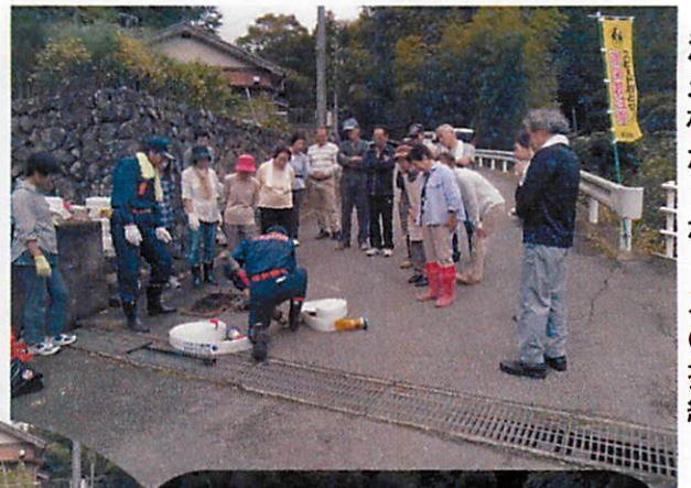
消火栓からホースの接続
