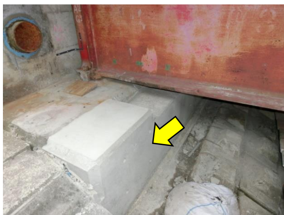
桁かかり長拡張工
