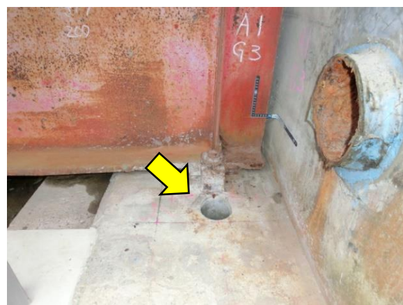
支承アンカーボルト孔削孔
