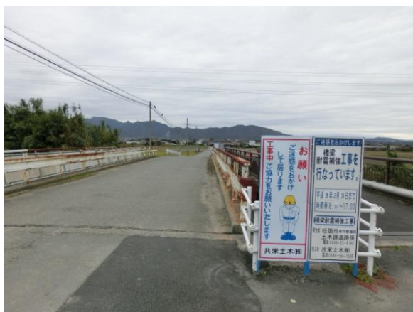
施工現場全景
