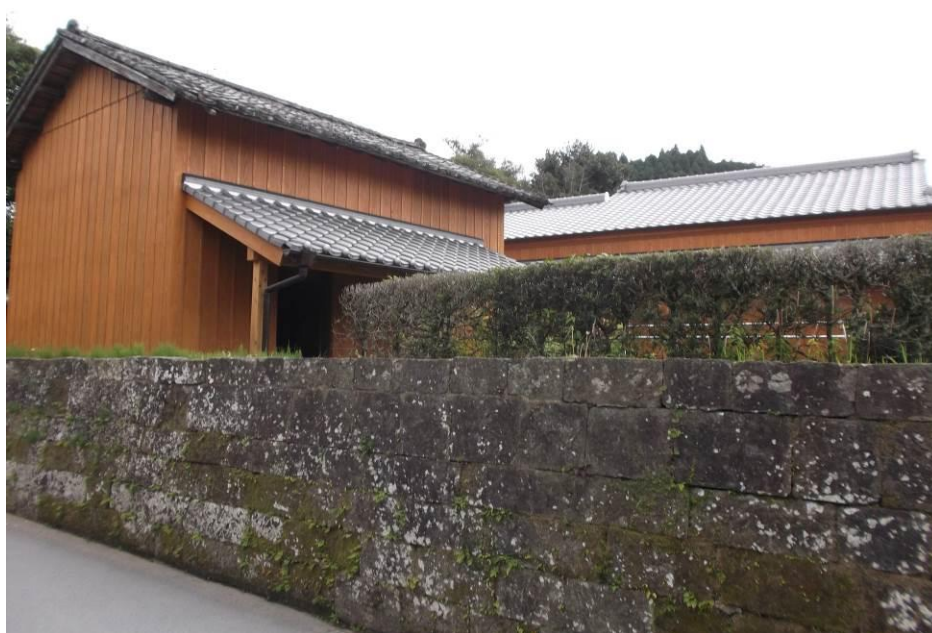
トタン張りの外壁を板張りに外観修理
