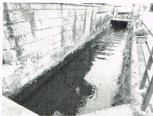
明和5年(1786)に造られた益山用水路
