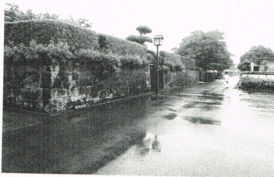
【日南市の伝統的建造物群保存地区】
